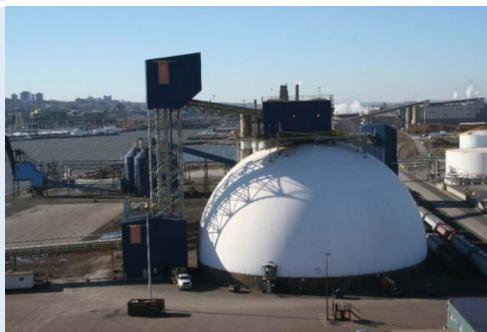
**Entreposage du concentré de nickel dans le dôme blanc et de la matre de nickel dans le réservoir bleu**
